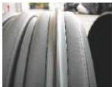
Positionner le joint sur la 1 ère annelure
