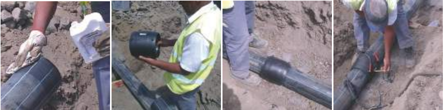
Application décapant
